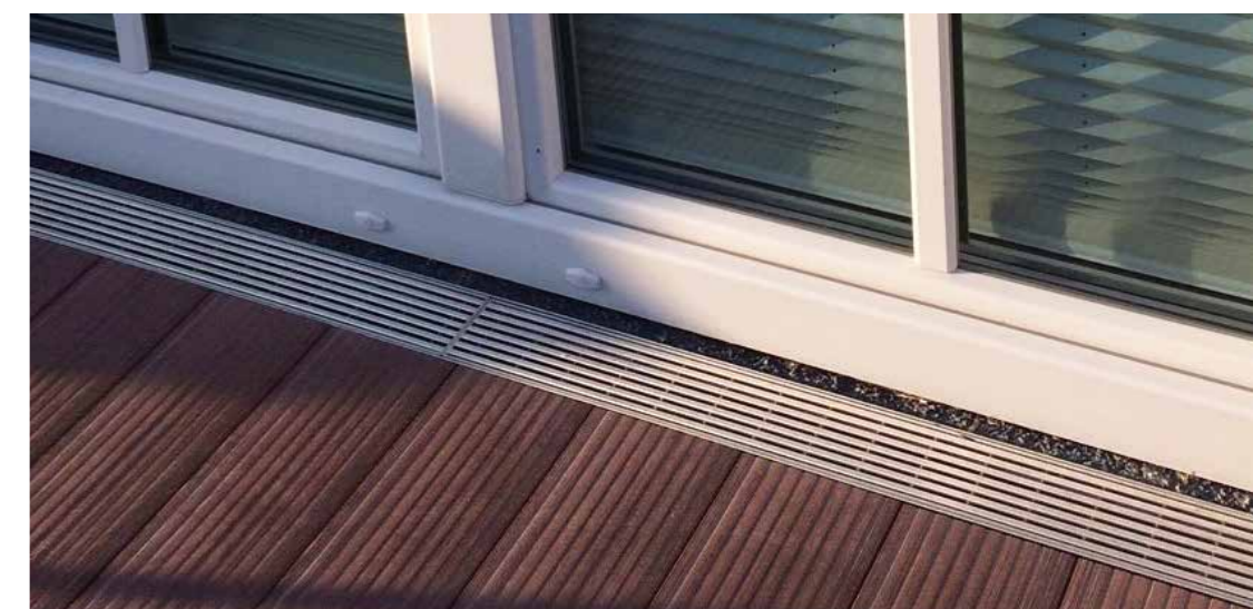
Nyitott fuga esetén csőcsatlakozás nélkül: ACO Self® Highline
